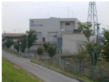
古川ポンプ場
