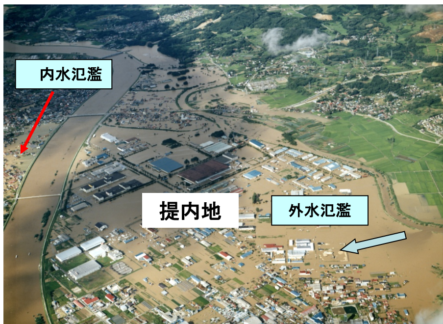
谷田川の破堤による郡山中央工業団地の浸水状況(昭和61年8月)
