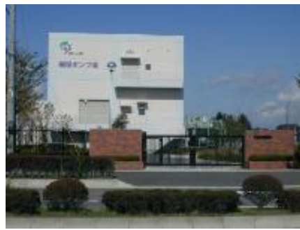
横塚ポンプ場
