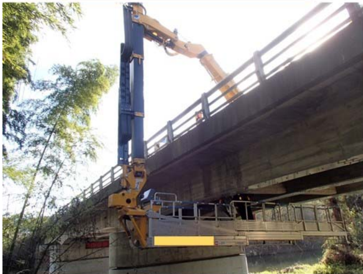
橋梁点検車による橋梁点検
