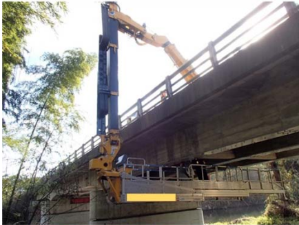
橋梁点検車による橋梁点検
